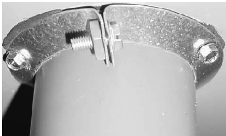
Figure 14 - Collier et joint d'étanchéité de l'évent
