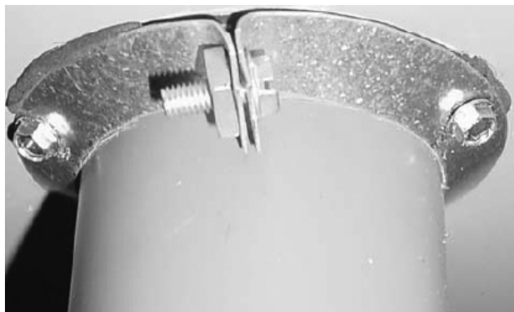
Figure 14 - Collier et joint d'étanchéité de l'évent
