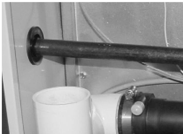
Les canalisations de gaz peuvent entrer dans l'appareil de chauffage des deux côtés. Une fois le parcours de la canalisation de gaz déterminé, choisir la paroi défonçable correspondante, l'ouvrir et installer l'œillet dans l'ouverture.
