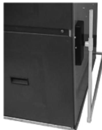
**Figure 27 : Conduits de dérivation des condensats**
