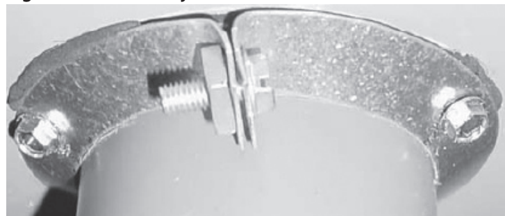
Figure 15 : Collier et joint d'étanchéité de l'évent
