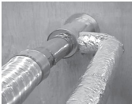
**5. INSTALLATION DE LA TUYAUTERIE D'ADMISSION D'AIR POUR LES SYSTÈMES À ÉVACUATION DIRECTE**
