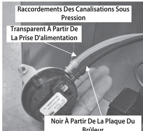
Figure 7 - Raccordement de la prise d'air de combustion
