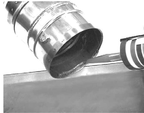
Appliquer une couche de silicone à la portion femelle de l'appareil/adaptateur de l'évent.
