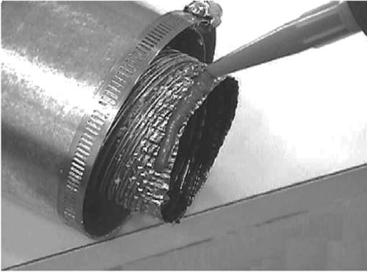
Appliquer une couche de silicone à la portion mâle de l'appareil/adaptateur de l'évent.
