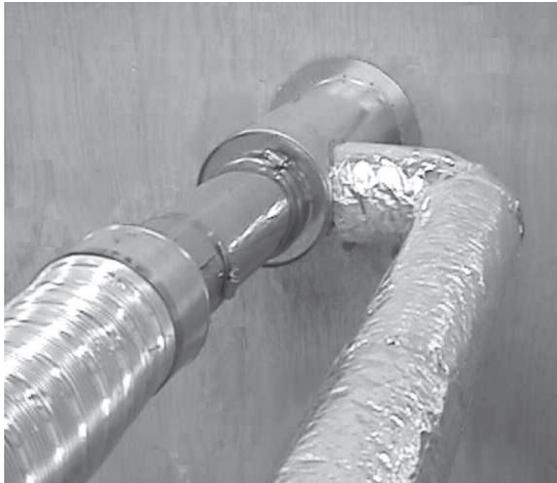
**IMPORTANT : Les raccords et les tuyaux d'entrée d'air doivent être scellés à l'aide de ruban métallique, de ruban adhésif ou de silicone de calfeutrage et fixés à l'aide de vis.**
