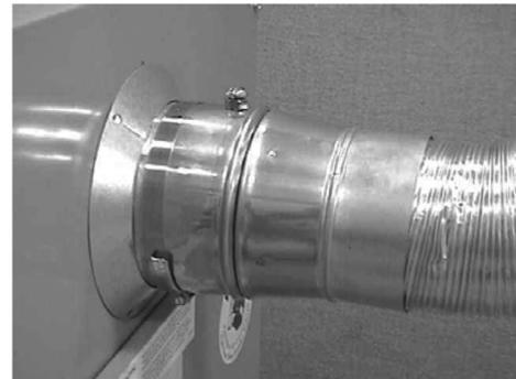
Raccord d'appareil type avec orifice de vérification..
