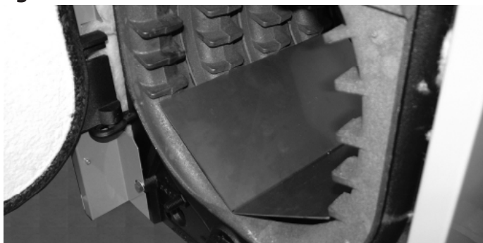
Figure 13 - Déflecteurs de 3 e passage
