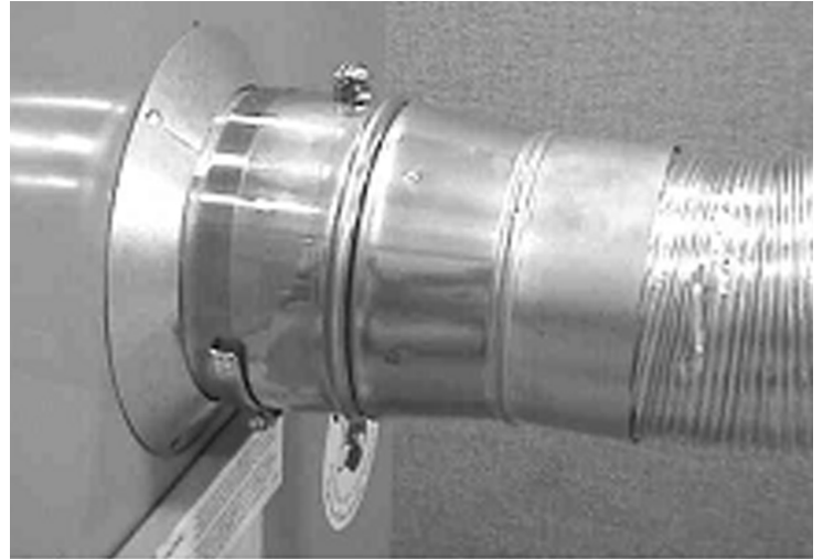
Figure 6 – Raccord d'appareil avec orifice de test
