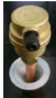
AÉRATEUR PLACÉ AU SOMMET DE LA CHAUDIÈRE
